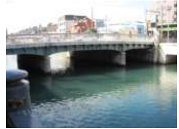
写真 一本橋(鋼橋)の全景
